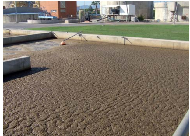
Foto 12. Línea 2 reactor 1 con dosificación de ozono en un solo reactor (12/11/2008)
